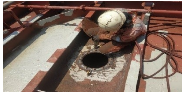
Gambar 3. Deck Seal MT. Ambermar Sumber : Dokumentasi pribadi
