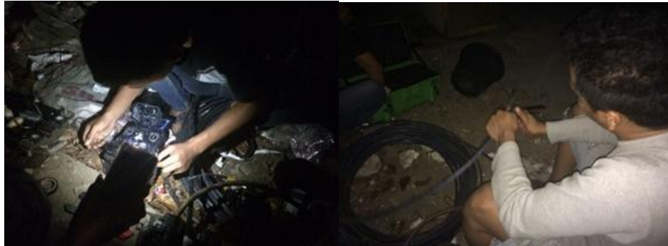
Gambar 15. Proses Pengupasan (kiri) dan Penyambungan Teknik Fusion (kanan)
