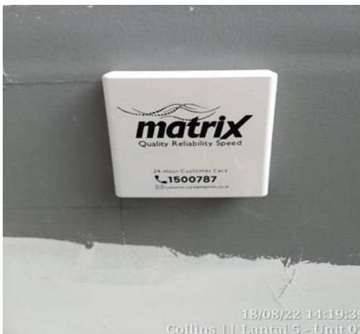
(Gambar 10. Pemasangan Roset di sisi Kamar Customer) (Gambar 11. Pengetesan Redaman Loss db di Roset Kamar Customer)
