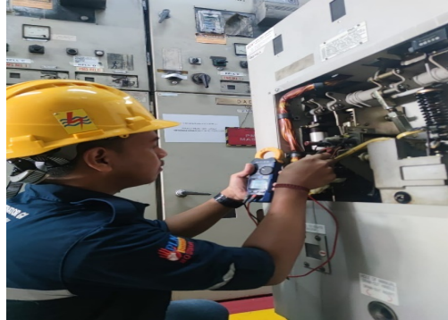
Gambar 2 Gambar Pengukuran Nilai Tahanan Tripping Coil Penyulang Kaca Piring
