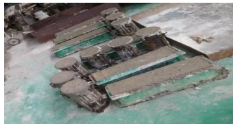
Gambar 3. Beton Segar Dalam Bekesting
